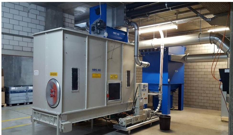
Abbildung 3: NBS Absauganlage vorbereitet auf die 2. Presse
